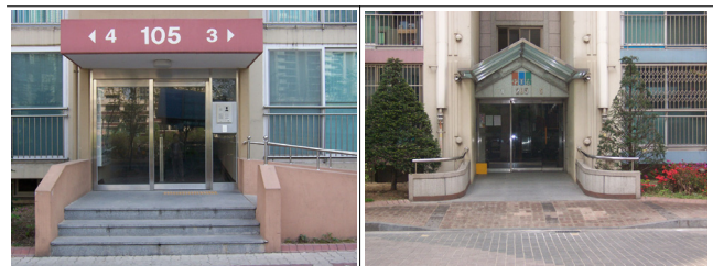
조사 대상 대부분의 단지에 설치된 경사로를 설치하지 않으면 접근성이 확보되지 않는 주출입구
