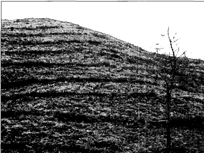
그림 3. 산불 후 토사유출방지를 위한 불타나무 수평쌓기(강원 삼척)
