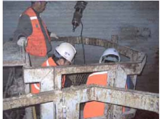
Fig. 5 터널내의 록볼트 인발시험 전경
