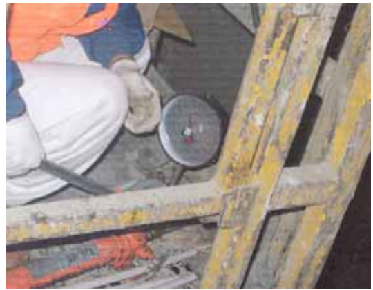
Fig. 6 터널내의 록볼트 인발시험 전경
