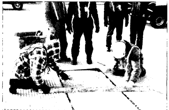
사진 3. 폴리머콘크리트 부분보수공법
