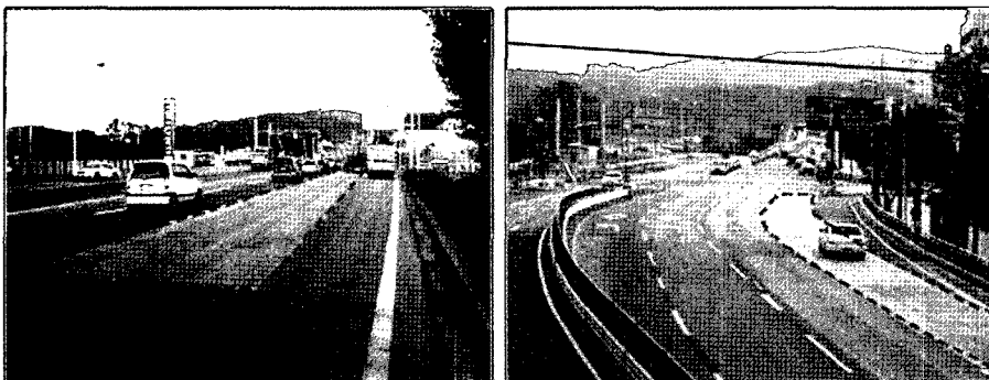
그림 7. 월전교차로(왼쪽)과 덕례교차로 시공 후 전경
