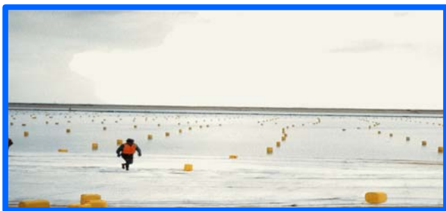
그림 9. 물통을 이용하여 보강매트를 부유
