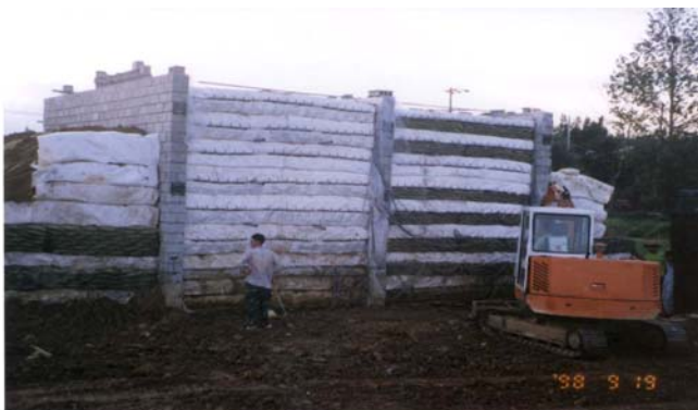
그림 4. 보강토벽 구축 직후의 사진
