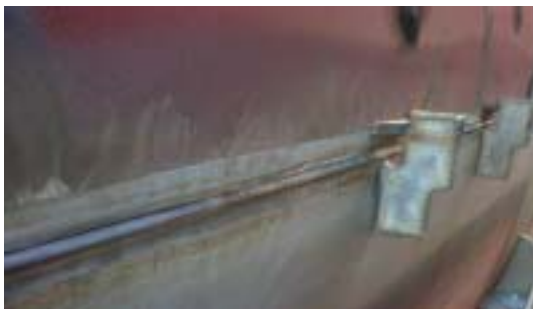
그림 13 선박 하부 취부용접 결과(용접 전압 40V, 전류 450mA)
