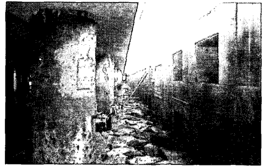
그림 4. 기초강관말뚝 및 소파블럭 설치
