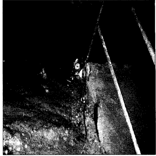
사진3. 관람객의 통로 중 경사면에 설치한 가드레일인데 녹이 슬고 위 구조물이 부실하여 관람객이 밀집되면 추락의 위험이 있다.(천용동굴)
