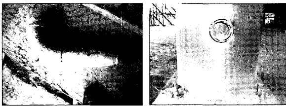
유도관(압입구 내 설치전) 입입구(유도관 설치후) 사진 8. 유도관 및 압입구
