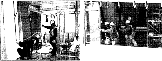
사진 16. C/W Unit 설치 사진 17. P/W Unit 설치
