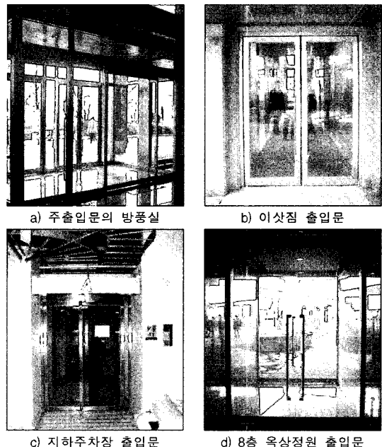
그림 8. 대상건물 저층부의 출입문
