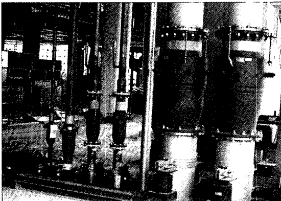
[그림 7] 수직배관의 내진지지 및 변위흡수이음 사진
