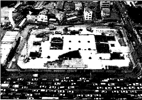
<2002년12월> 1층 Slab 형성
