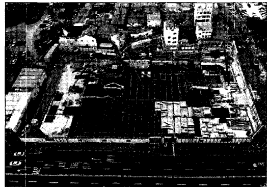
<1층 슬라브 공사>
