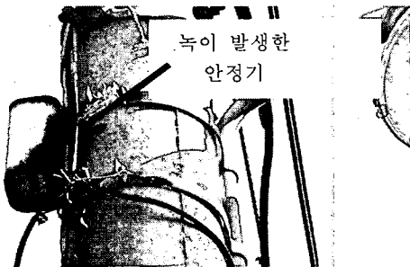
그림 4. B지역 전주병설의 사례 Fig. 4. An example a guard lamp installed on an electric pole in Area B
