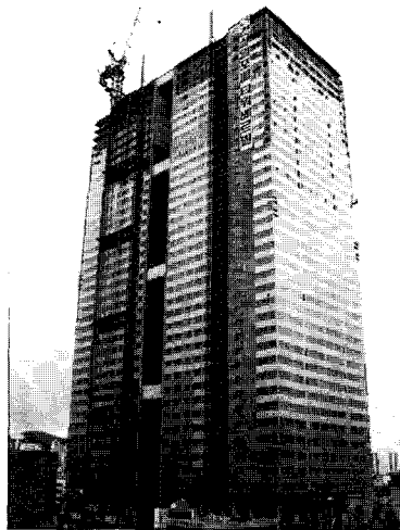
그림 14. 타워베르빌 공사 전경사진
