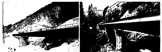
a. 압출에 의한 시공과정 b. 시공 완료 그림 2. 마츠노키교
