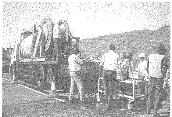
<그림1> 부유포설공법용 장비를 이용한 광케이블 포설
