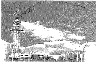
사진 3. 콘크리트 압송하는 전경
