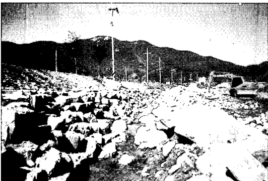
그림 7. 전석 쌓기 시공
