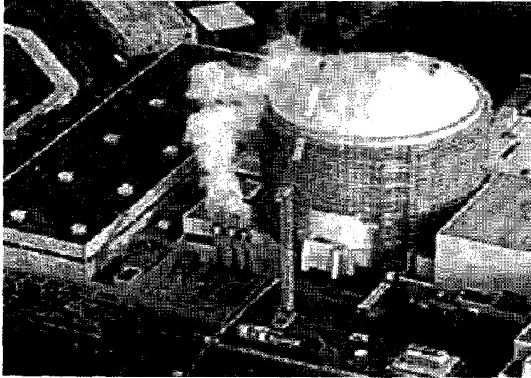
〈그림 1〉 사고 당일 미하마 3호기 전경
