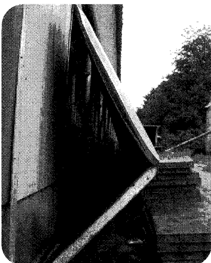
〈사진 4〉 스티로폴과 원치커텐을 접목한 돈사벽 단열·보온시설
