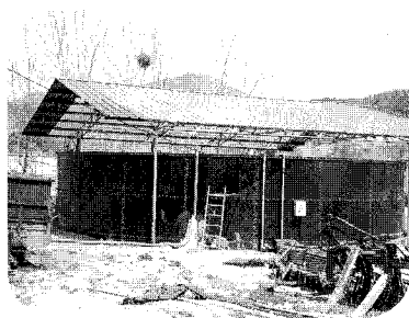
▲ 액비탱크 모습. 분뇨중 일부는 발효 처리로 액비화 하였으며, 경중농가에 액비를 직접 살포하고 있다.
