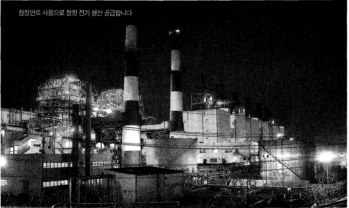
▲ 한국종합에너지(주) 인천 발전소 전경
