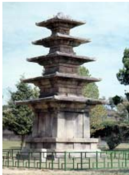
<사진 3> 定林寺址 5層石塔
