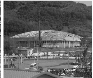
(h) 트리스돔 설치 전경
