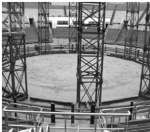
(d) 가설지주 설치
