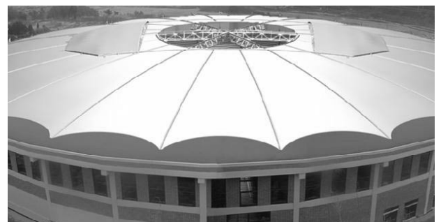
〈그림 2〉 경기장 전경 (지붕돔 설치후)
