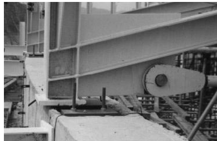
설치 직전의 트러스지지부
