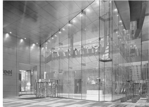
〈사진 8〉 1층 로비 DPG 커튼월
