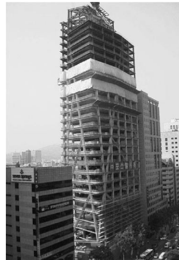
〈사진 9〉 공사 전경
