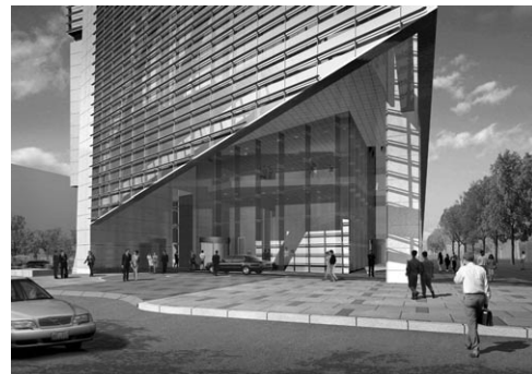
〈사진2〉 북동쪽 모서리부 저층부 전경
