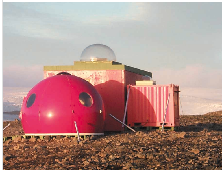
세종기지에 위치한 고층대기관측실의 모습. 건물지붕에 설치된 투명돔을 통해 고층대기에서 방출하는 복사선(대기광, 오로라)을 관측한다.
