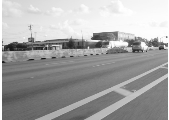
[사진 1] CRCP 위에 아스팔트 덧씌우기 한 포장
