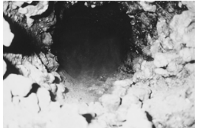
그림 3) 결절이 형성된 본관에서 볼 수 있었던 바와 같이, 조도 증가 및 흐름 영역의 감소로 인해 관벽 부식은 수리학적 용량에 큰 영향을 미친다.
