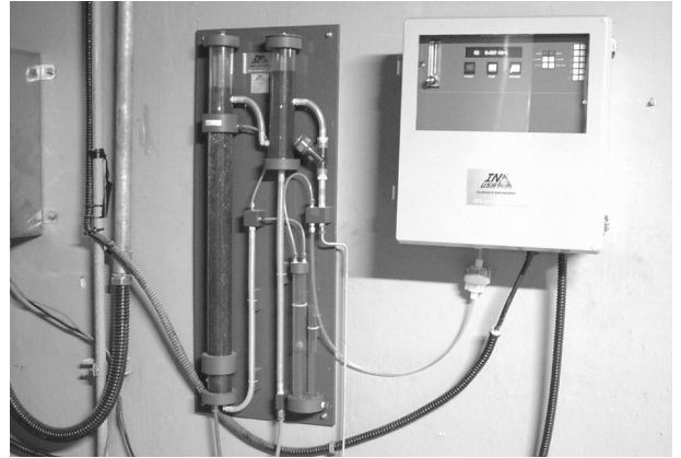
그림 4) 후오존 접촉조에 설치된 잔류오존농도계
