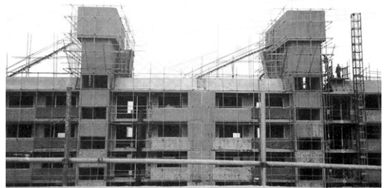
[사진 3] 옥탑 방망 설치
