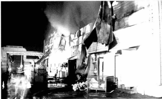
[사진 11] 샌드위치패널 외벽 강판이 떨어져 내린 개구부로 연기가 배출되고 있는 모습
