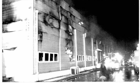
[사진 10] 진화작업 중인 건물 전면 소방차와 소방대
