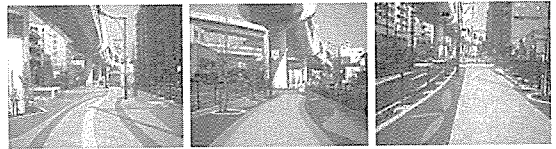
Fig. 4 일본의 유리재생 칼라수지포장도로 시공 사례
