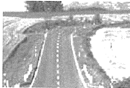
Fig. 3. 파유리를 이용한 아스팔트 포장
