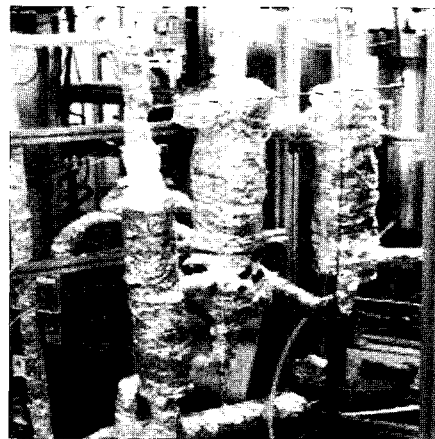
Fig. 10. 5 kW급 가압형 prereforming system.
