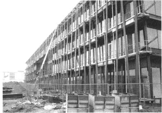
Fig. 4. 빗물을 이용한 냉방시설 시공(독일).
