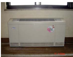
⑧ 교실 바닥 콘솔 설치
