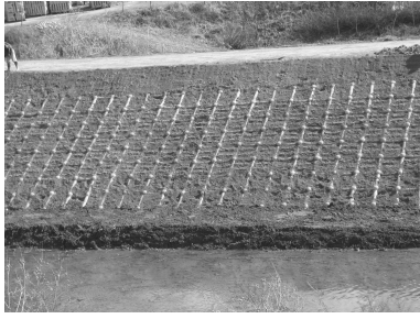
시공완료 후의 전경
