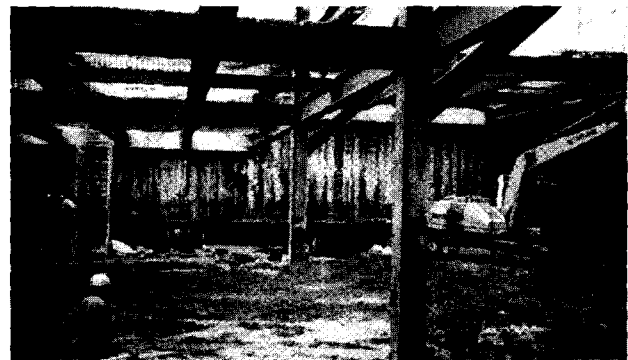
그림 10. 지하 2층 SPS 프레임 설치현황
