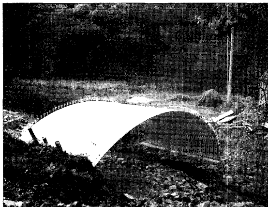
그림 1. 파형강판을 이용한 국내시공사례(소규모 교량 및 수로용 암거)
