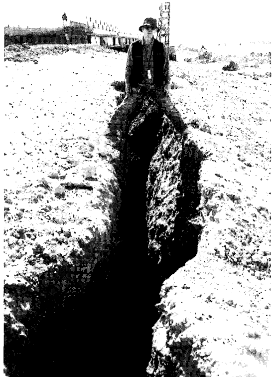
그림 10. 수라즈바리 교량(사면의 균열)
