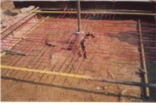
Fig. 3 시험앵커 인발시험 후
