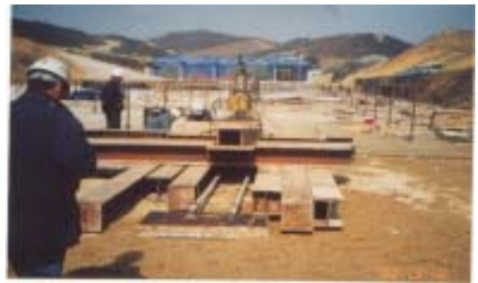
Fig. 2 본 시공 앵커 시험전경
