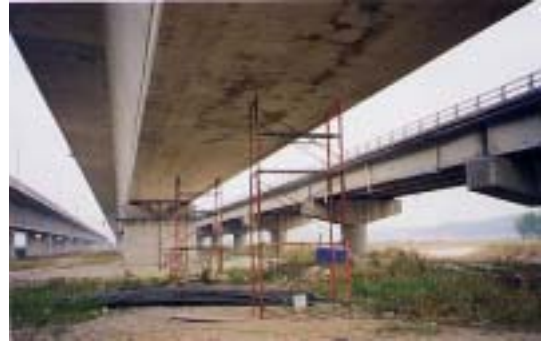
Photo 1 실험대상교량의 박스단면 전경
