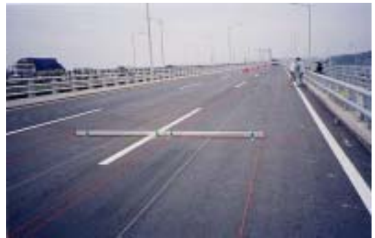
Photo 2 하중위치 및 충격실험 설치 전경
