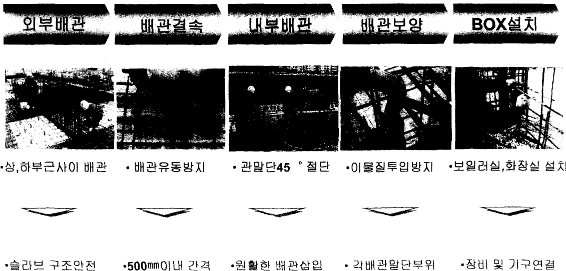
[그림 2] 이중관 공법 시공순서
