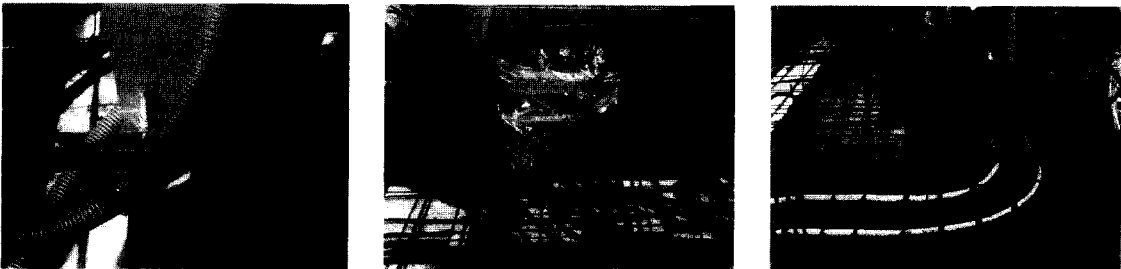
[그림 10] 난방분배기 고정 및 연결배관작업
