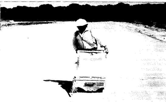
그림 5. 콘크리트 커터를 이용한 종방향 줄눈의 설치
