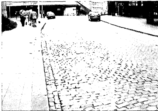
(e) 도심부 블록포장 파손 예
