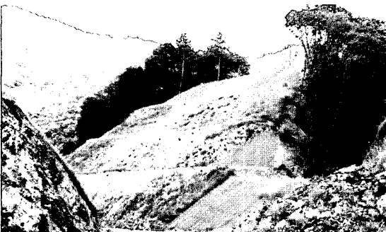
사진 1. 덕유산국립공원 진입로, 주변환경과 이질감 및 산사태 광경
